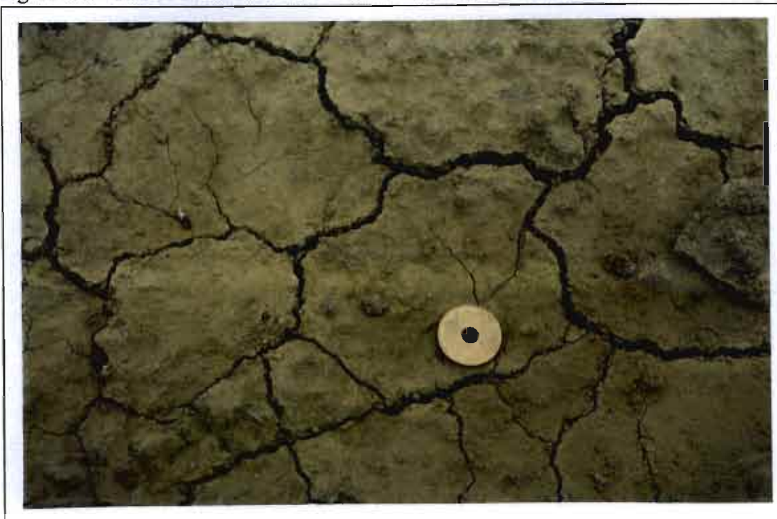
Figura 5.6.- Grietas de retracción en el fondo de las balsas de infiltración.
